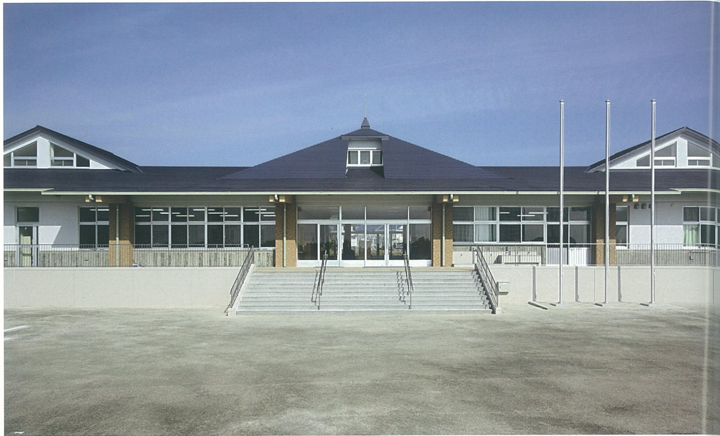
運動場側より昇降口を見る。昇降口は、正面玄関～運動場を自由に行き来できるように教室棟を縦断するように配置した
