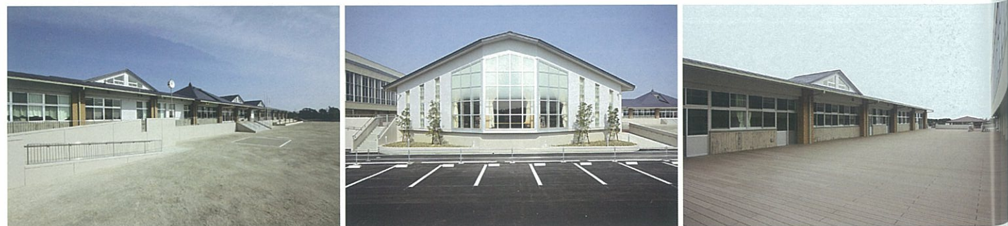
左|普通教室棟。各教室前には、運動場と建物との段差を利用した学級園 中|特別教室棟。南側には図書館を配置。そこからは南側の太平洋を一望できる 右|特別教室棟と既設屋内運動場間に整備したウッドデッキテラス。災害時には屋内運動場と連結し、避難所としての運用が可能
